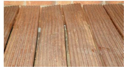
**Wechsel-Dreh-Wuchs:** Harthölzer neigen teilweise stärker zum sogenannten Wechsel-Dreh-Wuchs. Es ist daher besonders wichtig, dass die empfohlenen Abstände zwischen den Auflagerepunkten auf der Unterkonstruktion eingehalten werden, damit das Holz „gehalten“ werden kann.
